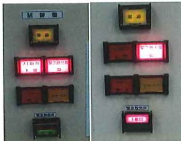
自動、手動にて緊急放出弁動作確認
